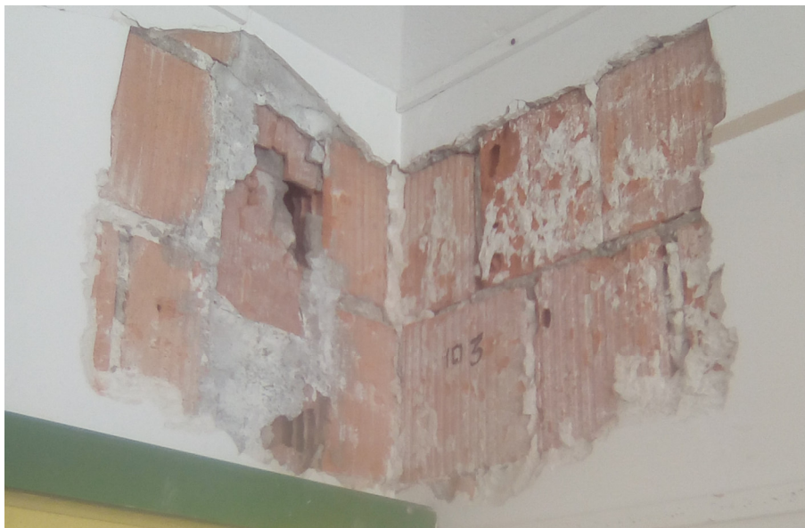
Figura 11 - rilievo della tessitura muraria ID4
