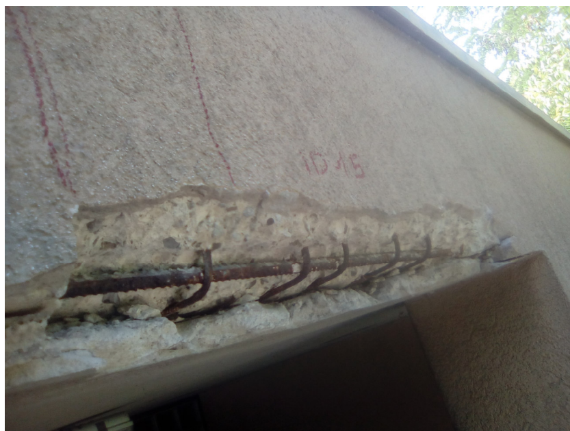
Figura 6: rilievo armature nella trave
