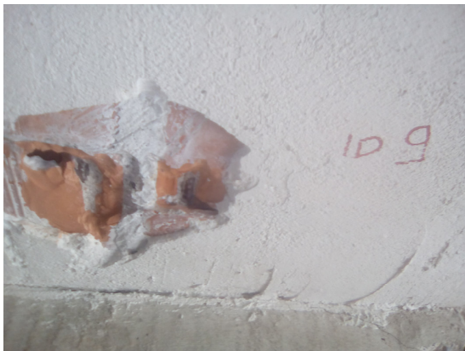
Figura 13 – Saggio di solaio ID9
