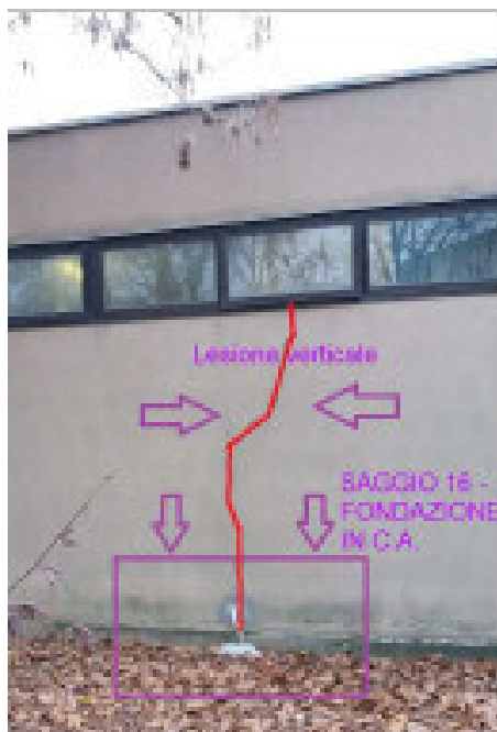
Figura 14 - ubicazione scavo di fondazione
